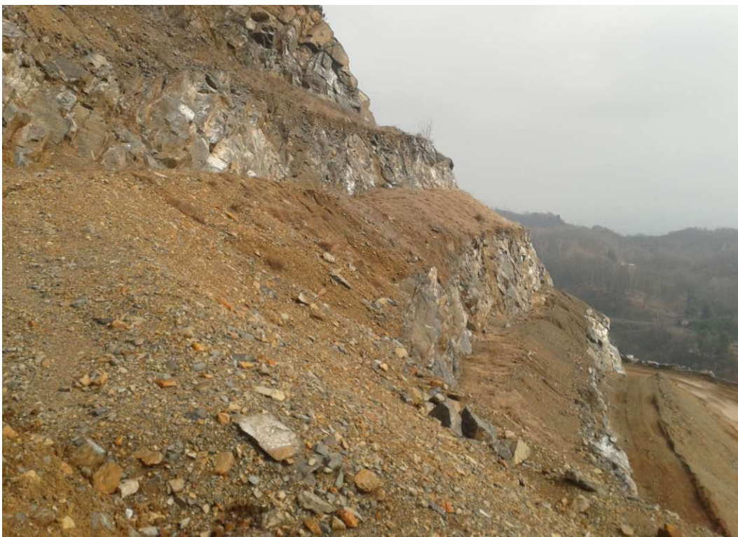
Particolare dei riporti morfologici in materiale detritico, finalizzati al recupero delle pedate dei gradoni superiori, dismessi dalla coltivazione mineraria (febbraio 2016).
