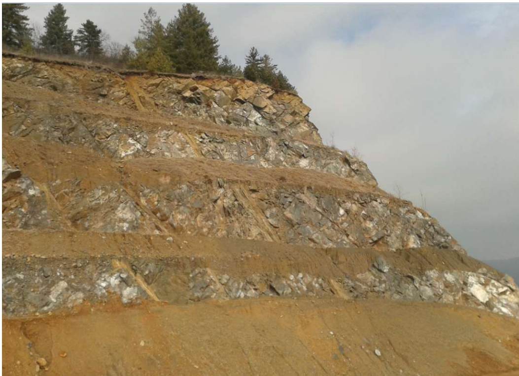
Ripristino morfopedologico dei gradoni sommitali dismessi dalla coltivazione, nel settore sud – occidentale della miniera (febbraio 2016).
